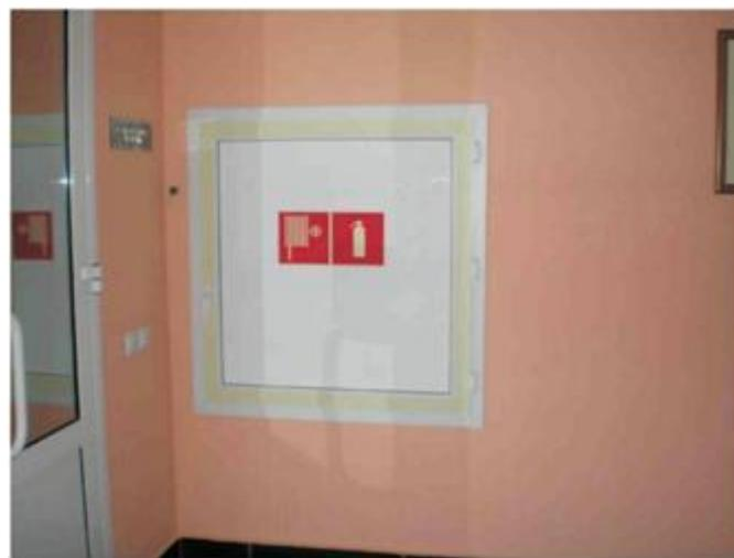
Рисунок А.6 - Обозначение фотолюминесцентной 50-мм лентой контура пожарного оборудования и использование знаков пожарной безопасности
